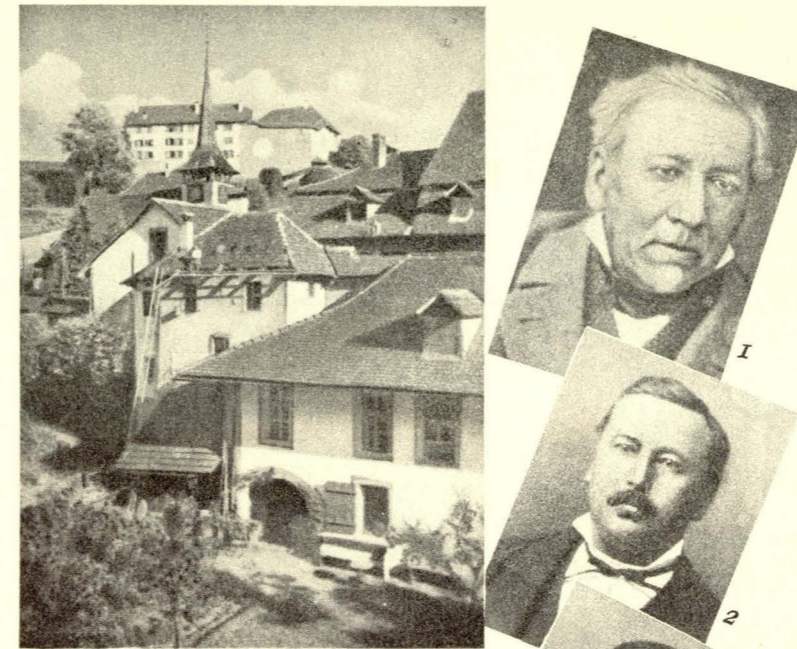
Haus mit Dachdecker: altes Schulhaus von Norden. In dem Raum mit 2 Fenstern wurde im Jahre 1853 die Kartonnagefabrikation aufgenommen. Das anstossende Haus von rechts ist das Hinterhaus vom damaligen Posthalter Ruprecht (Strählsagers). Das Lokal mit 3 Fenstern ist 2 Fenster grösser und wurde bis 1866, bis die neue Fabrik am Grabenweg erstellt war, benutzt.
