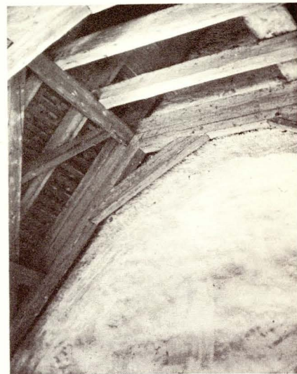
Abb. 7 Dachstuhl des Chores und Wand oberhalb des Triumphbogens, am Rand mit Spuren von Ornamenten aus der Zeit vor 1764. (Foto H. v. Fischer)
