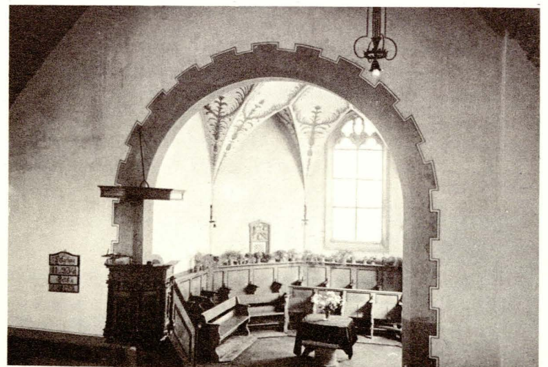
Abb. 9. Zustand des Chores vor dem Umbau von 1958: Künstliches Spitzbogengewölbe; alte Chorstühle, die das Sakramenthäuschen verdecken; der Fuß des Taufsteines steckt im Boden (Foto Th. v. Lerber, 1939).
