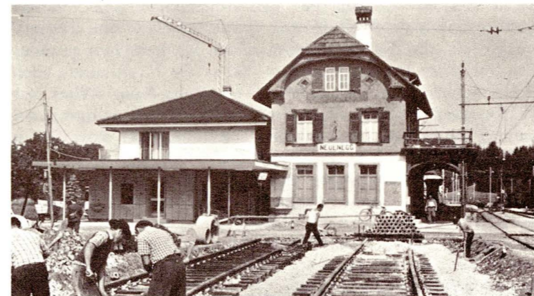
Neueneegg, Sommer 1965. Altes und neues Stationsgebäude nebeneinander Foto Blumenstein
