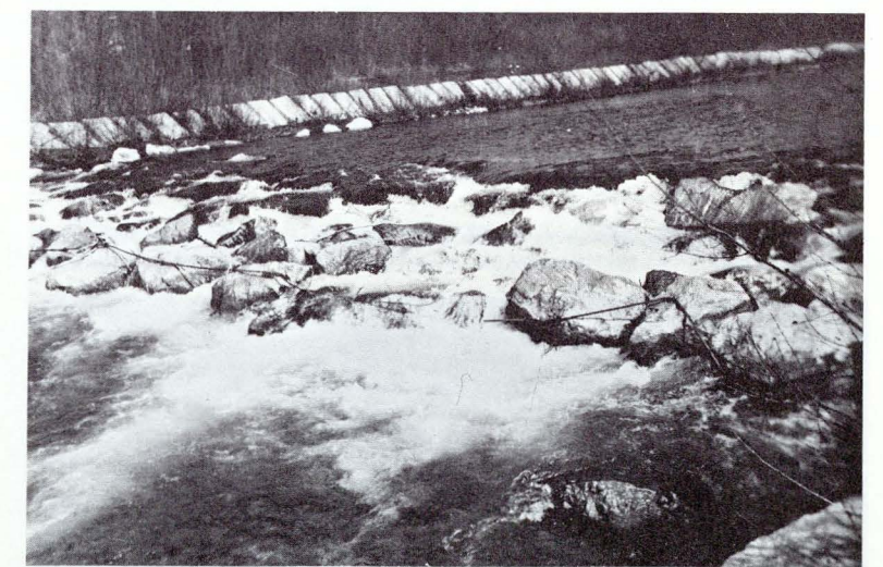
Mit der Anlage von Querriegeln will man das Geschiebe zurückhalten und eine weitere Absenkung verhindern (unten). Im Hintergrund die heutige Art der Uferverbauung mit Betonblöcken (Foto Jos. Noth).
