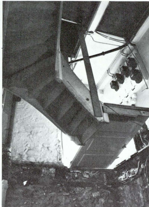
Während dem Umbau sind Provisorien (Installationen, Verkehrswege) unumgänglich.
