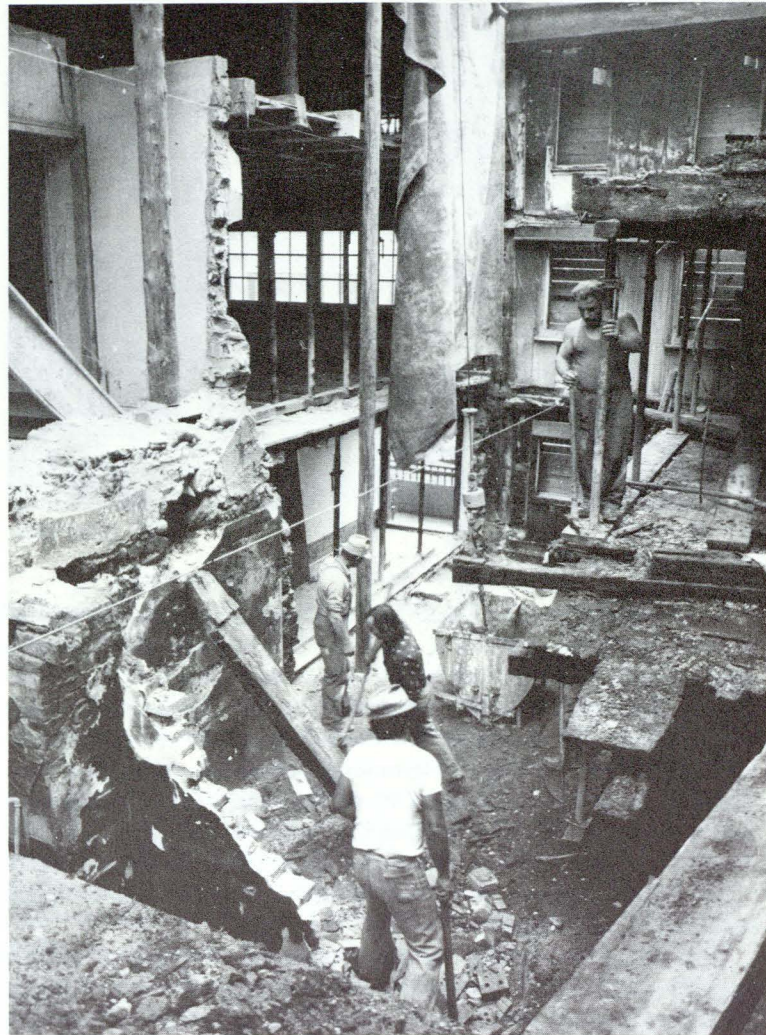
Läublihäuser Laupen. Abbruch der alten Haustrennwände und Einbau von neuen Brandmauern. Foto: Stünzi
