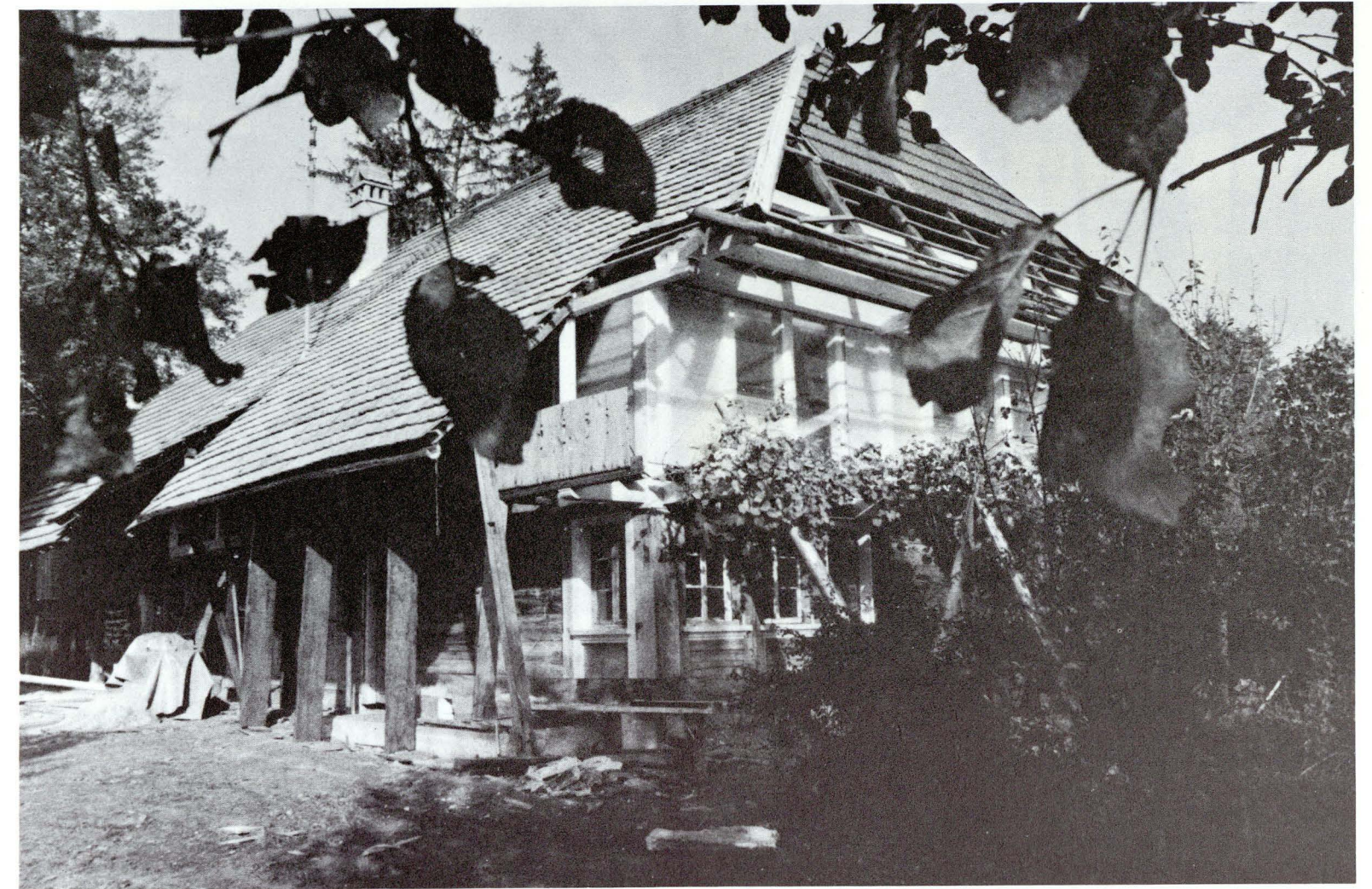
Die Erneuerung ist in vollem Gange.
