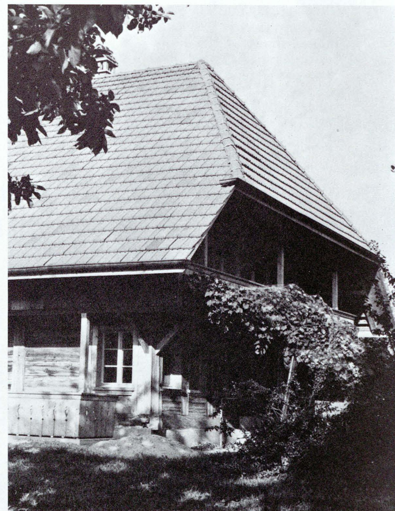
Schürholz, Erneuerung eines vorher unbewohnbaren Bauernhauses.
