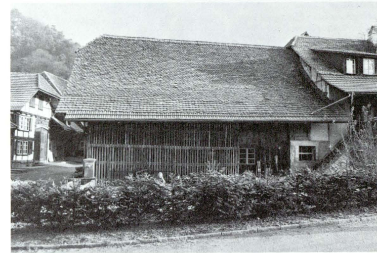
Zustand vor dem Abbruch
