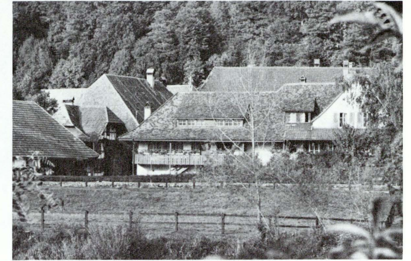
Der Neubau heute
