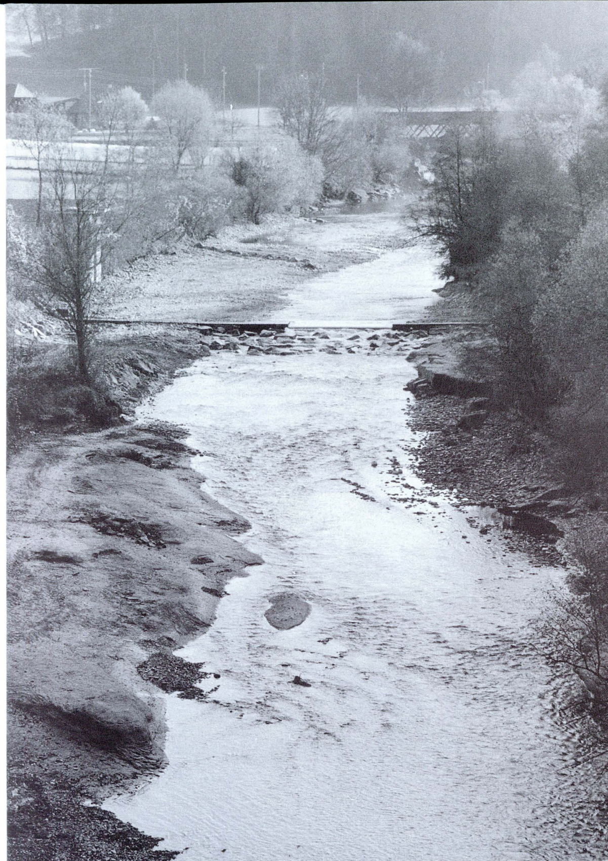
Der «Rusch» von der Eisenbahnbrücke her flussaufwärts gesehen. Unter der Schwelle liegt eine ARA-Röhre. Die Stufe ist mit Steinblöcken soweit entschärft, dass sie für Fische kein unüberwindbares Hindernis mehr darstellt.
