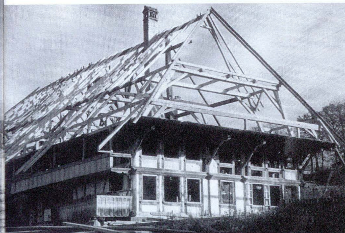
Ein sorgfältiger Abbruch 1973.
