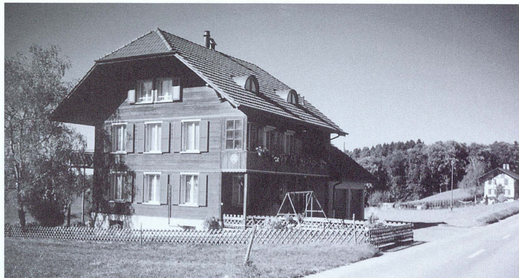
Daraus entstand ein Wohnhaus.
