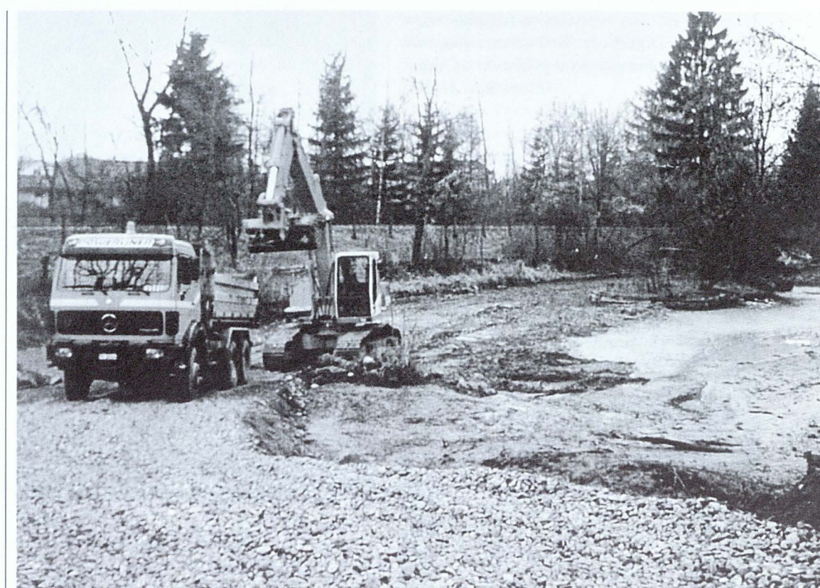
Abtransport Schlamm, Absenkung Sohle in Molasse und Schotter
