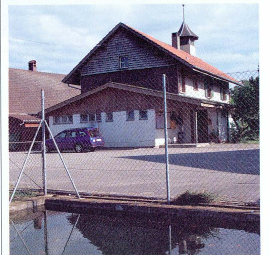
Der Feuerweiher beim Schulhaus wird aus dem Überlauf des Reservoirs gespiesen
