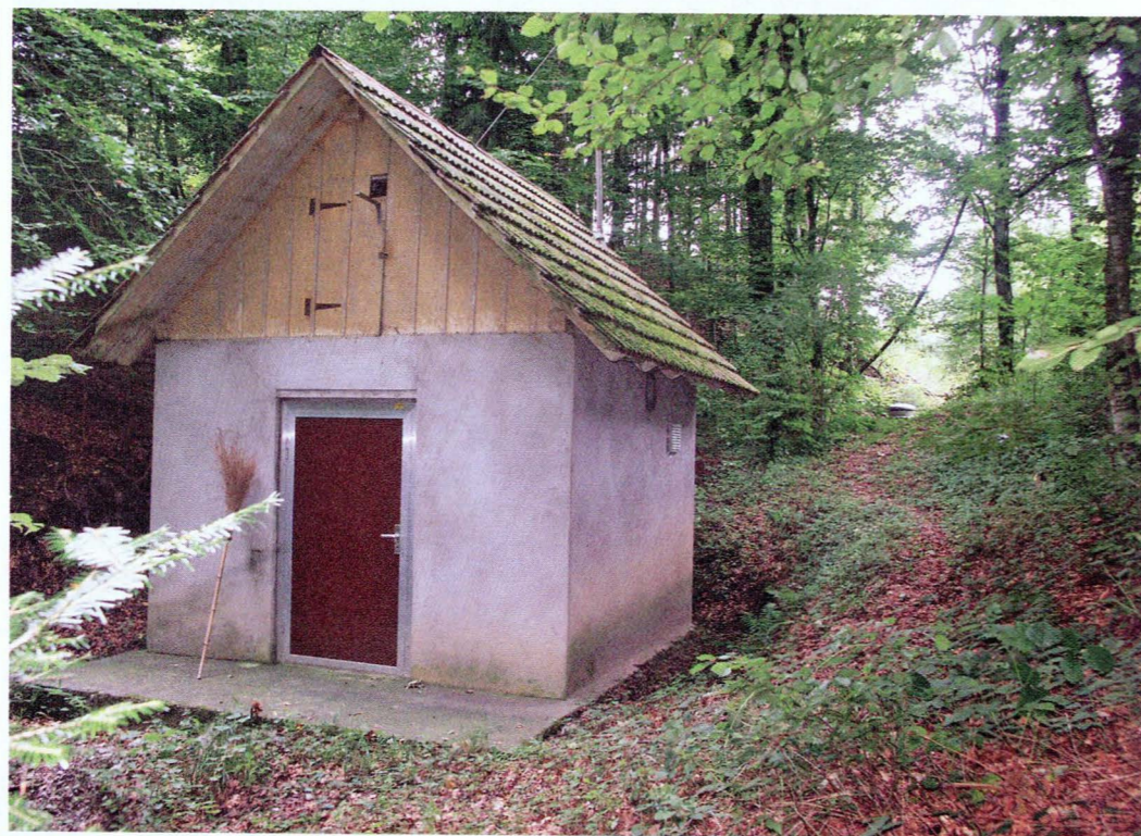
Das Pumphaus im Favrewald, im Hintergrund eine Quellfassung
