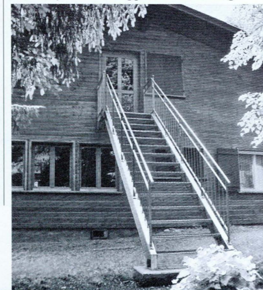
Die stützfreie Stahlterrasse als Notausstieg.
