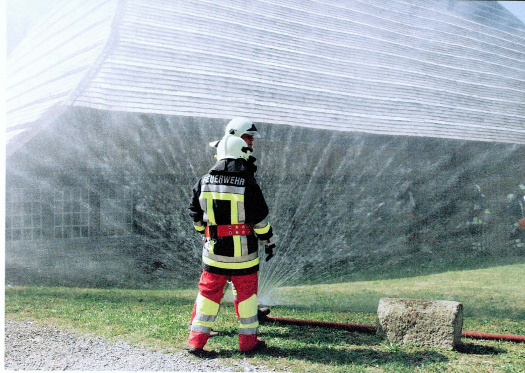
Wasservorhang der Feuerwehr vor dem neuen Schindeldach
