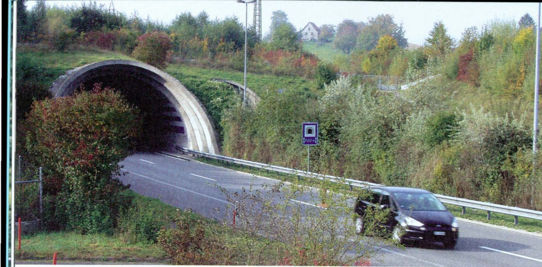
Autobahn A1: Tunnel «Les Vignes».
