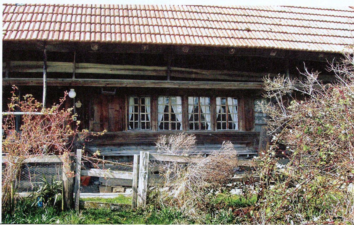
Hermann Baumanns denkmalgeschütztes Hochstudhaus aus dem Jahr 1658 (Strassenseite)
