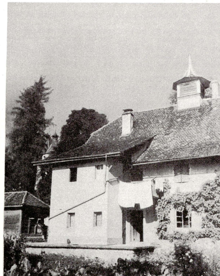
Das Schulhaus von Südwesten — vorher
