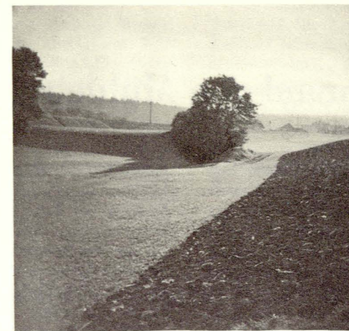
Unterstes Becken: Blick vom Berglirain über die Schwellimatte nach dem oberen Damm.
