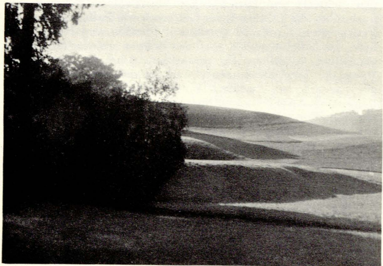
Unterer Damm mit Bergflirain.
