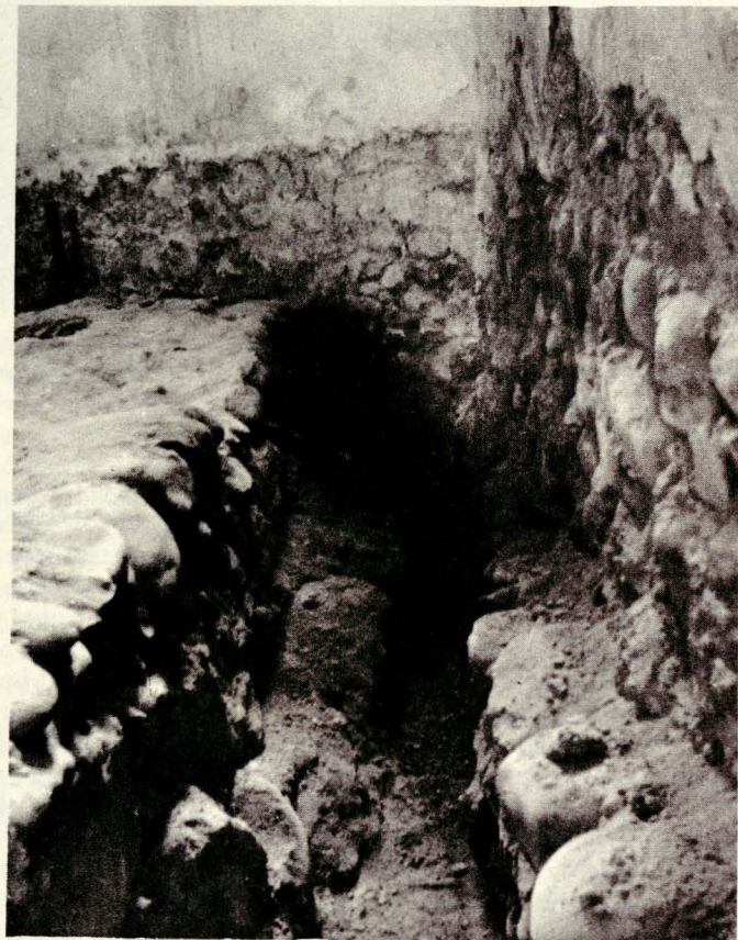
Abb. 3. Verbreiterung des Fundamentes am südl. Teil des vier-eckigen Chors (Ziff. 5a des Planes); rechts und hinten die bestehende Chorwand. (Photo H. v. Fischer)
