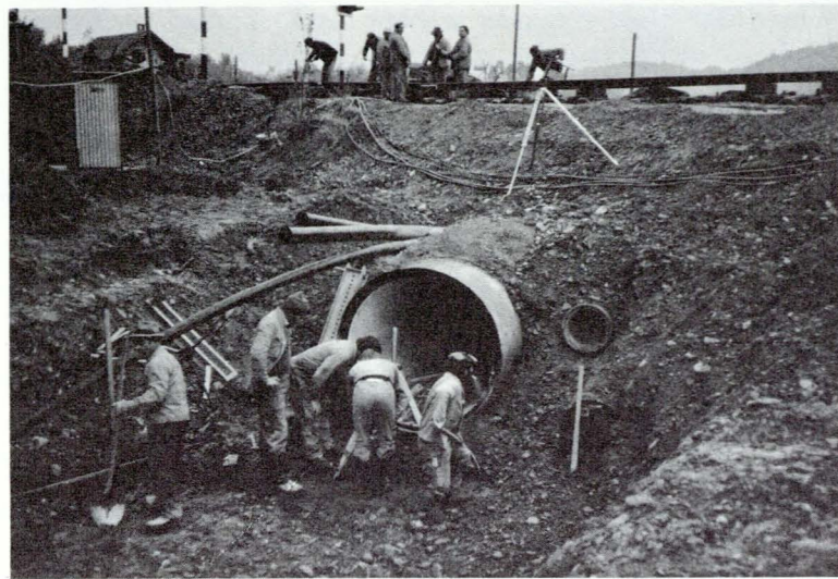
Unterquerung des Sensetalbänddamms an der Schützenstraße in Laupen
