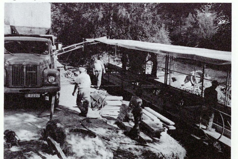
Enge Platzverhältnisse bei der Erstellung des Ortsbetonkanals in Laupen
