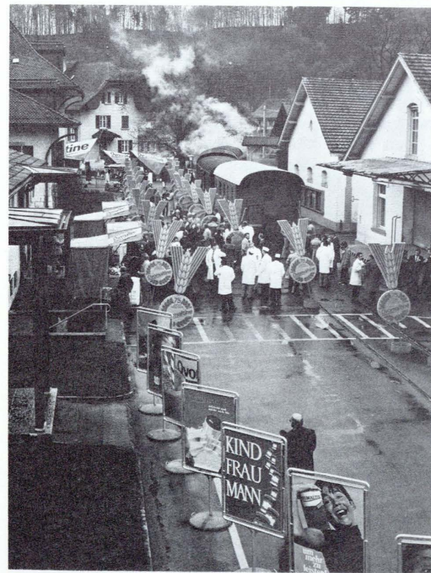
Gerüstet für hohen Besuch
