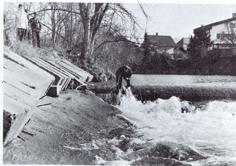
Der markanteste Riegel beim Bahnhof Laupen. Der Fluss wird durch die Technik bezwungen.
