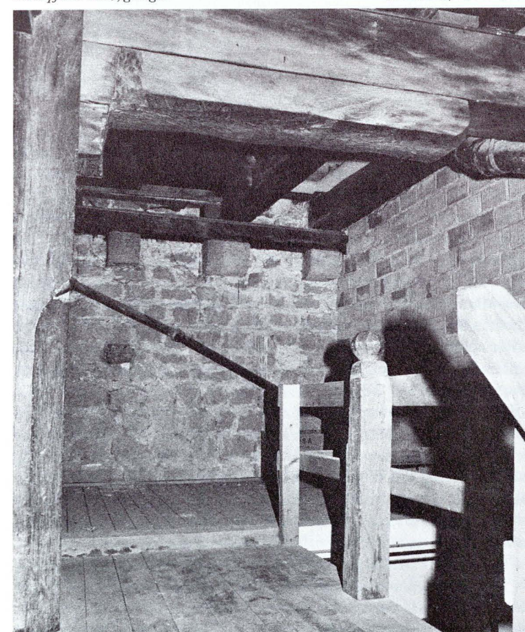
Die Balkendecke des Rittersaales wird von einem Unterzug, der sich auf einen reichbearbeiteten Eichenpfosten stützt, getragen.
