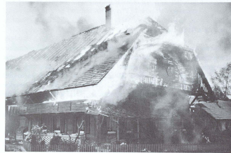
Auch der Wohnteil wird bald ein Raub der Flammen.
