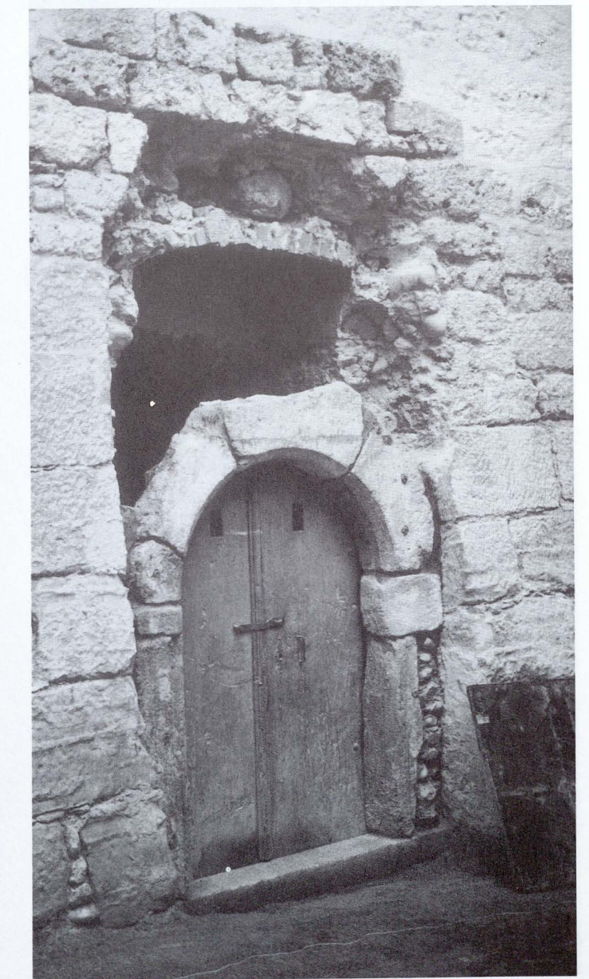
Rückversetzen der Kellertüre auf die ursprüngliche Lage.
