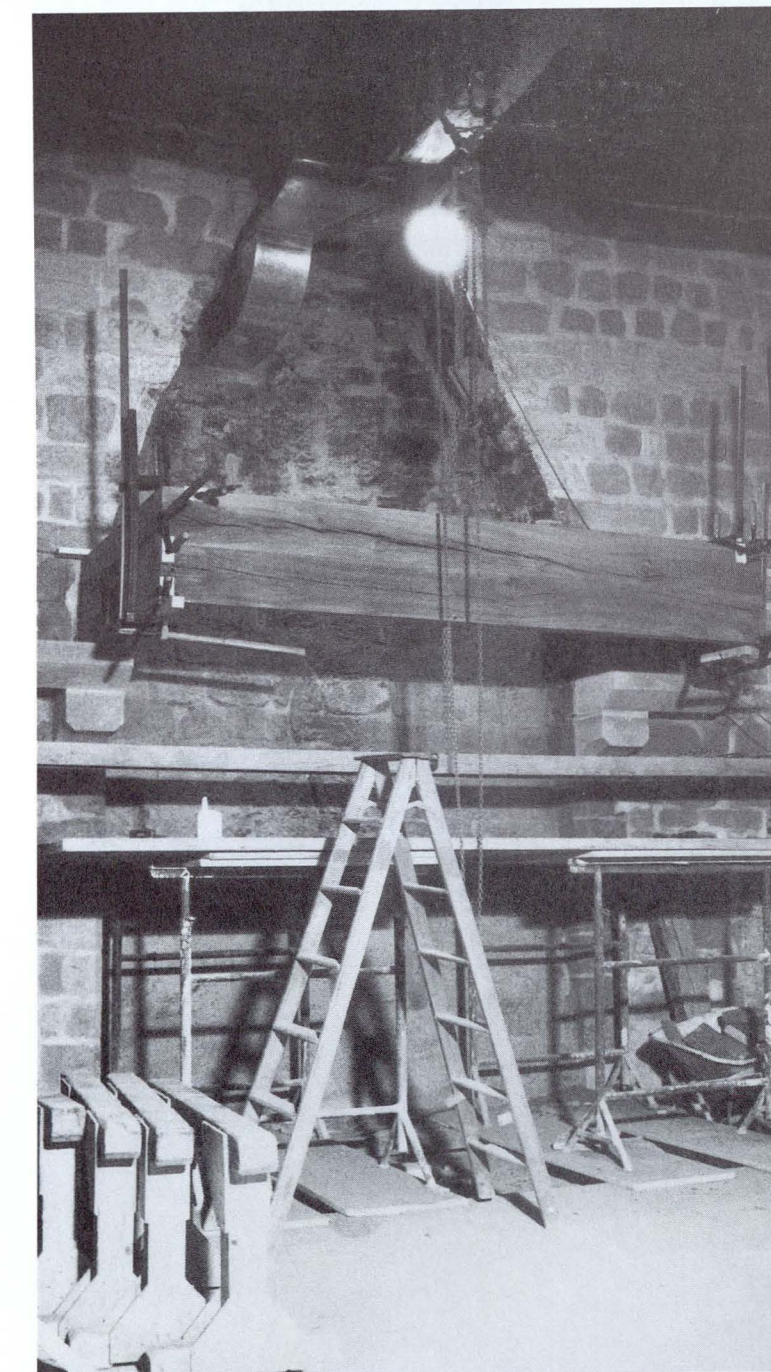
Rekonstruktion des Kamins im Palasaal.
