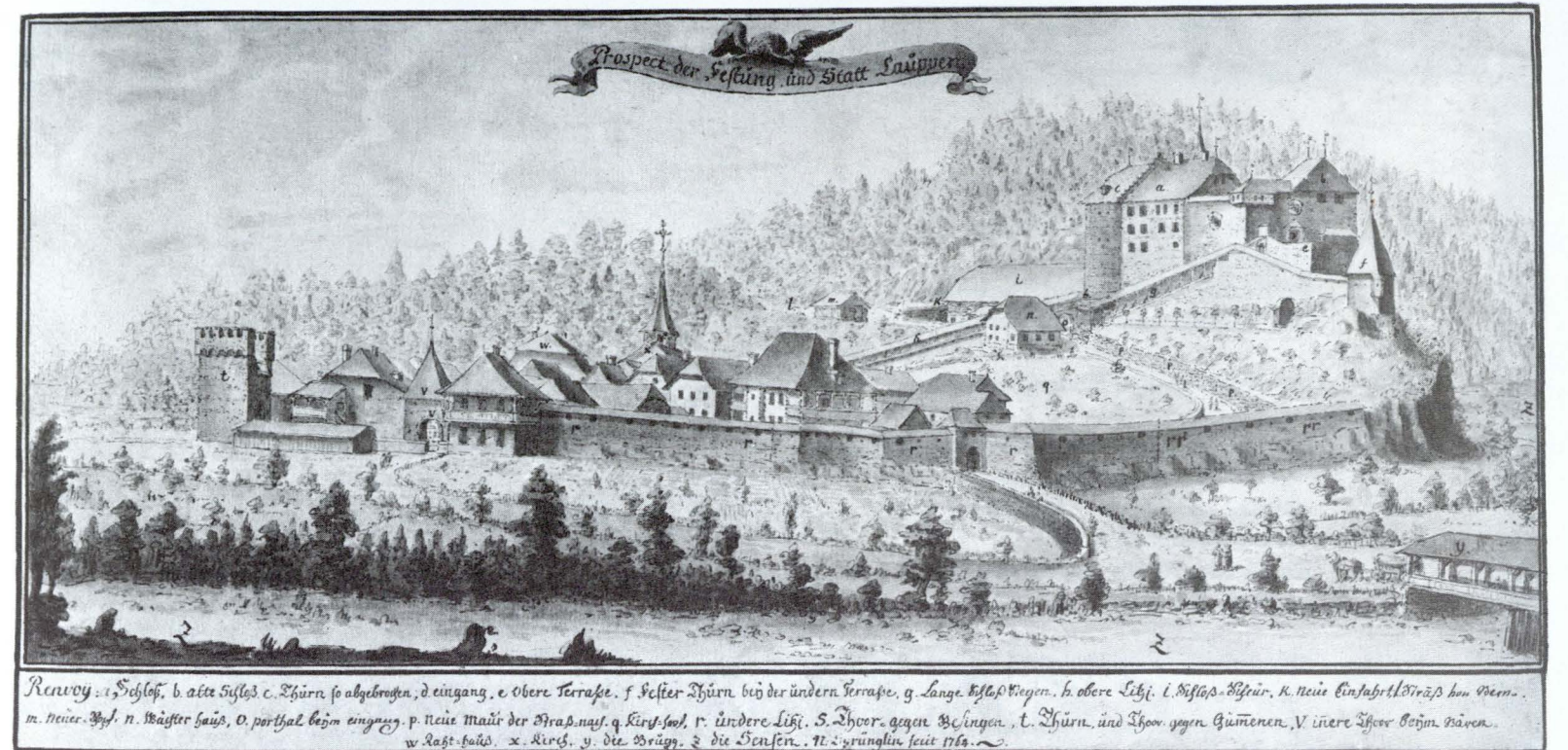
Sprüngli: Werkmeister Niklaus Sprüngli reduzierte den Bergfried auf die Höhe des «Neuen Schlosses» und die östliche Wehrmauer auf die heutige Höhe. Er legte auch eine kutschierbare Zufahrt durch die Scheune an. Zeichnung von 1764.
