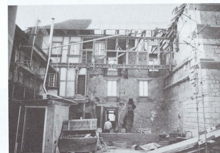
Verbindungsbau Sommerlaube-Palas im Bau.
