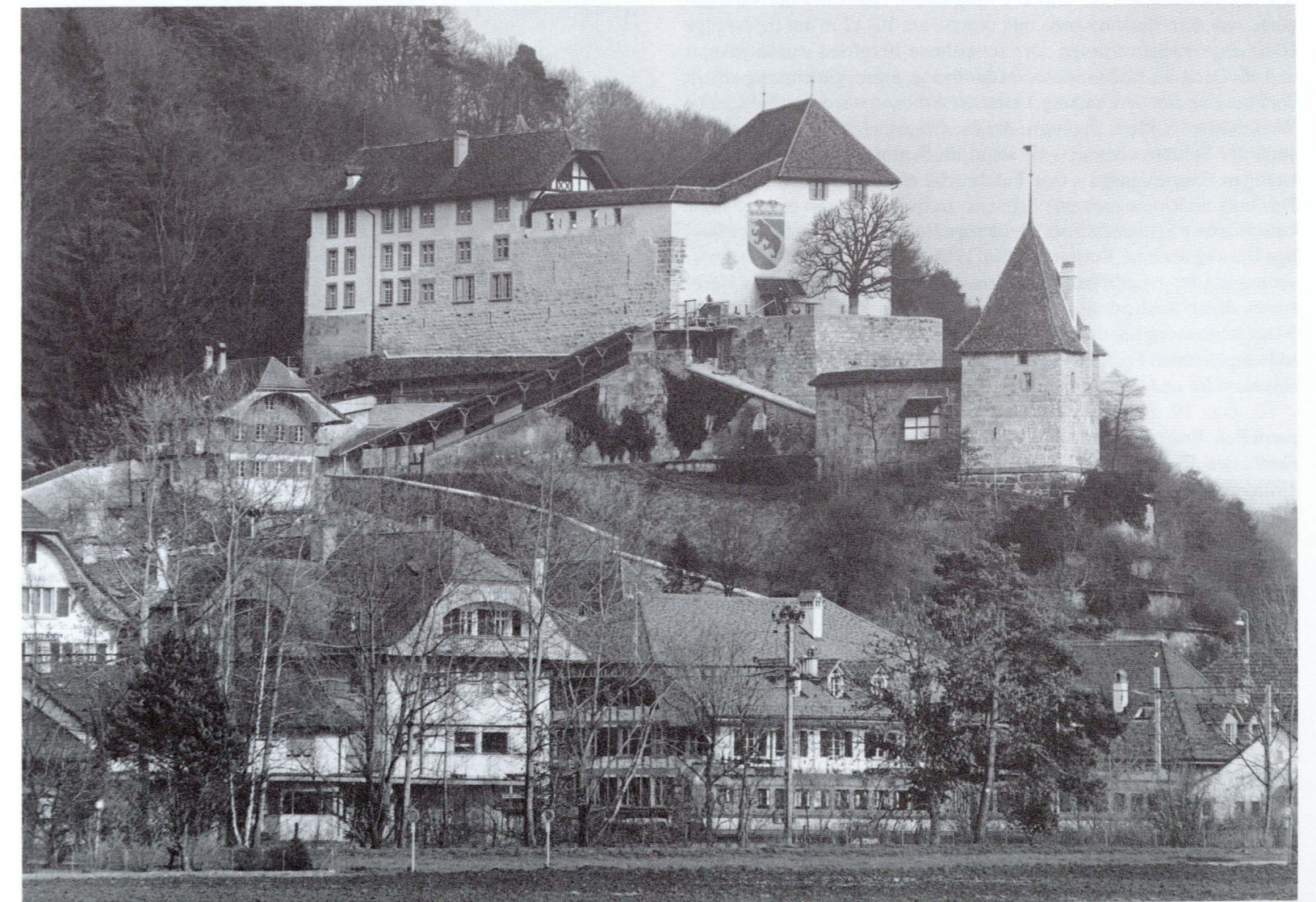
Schloss Laupen. Ansicht von Nordwesten. Die an den ehemaligen (hell verputzten) Bergfried anschliessenden Ringmauern bilden ein System von terrassierten Höfen mit dem ursprünglichen Zugang. Die gedeckte Treppe der Zeit um 1600 kürzt ihn diagonal ab.
