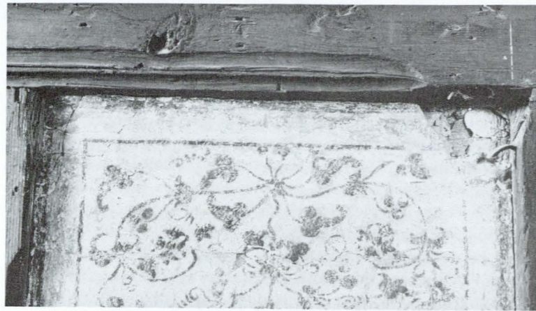
Im Westabschnitt des Palas-Obergeschosses ist die spätmittelalterliche Ausstattung unter Verschaltungen des 19. Jh. gefunden worden: Riegwand mit Arabeskenmalerei um 1500. «Sachwzänge» nötigten, sie wieder unter Verschaltungen verschwinden zu lassen.
