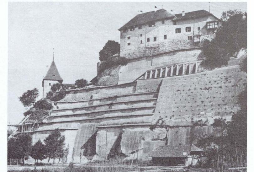
Schlossfelsens nach der Sanierung, Zustand November 1925.
