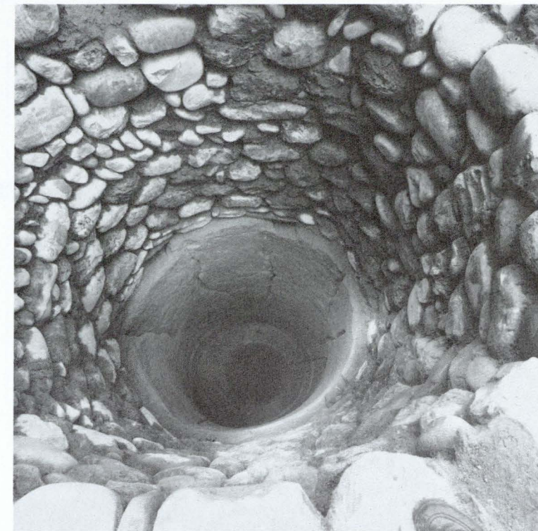
Detail des Sodbrunnens auf der Westterrasse. Deutlich sichtbar ist die Verengung im direkt aus dem Felsen gehauenen Schacht.
