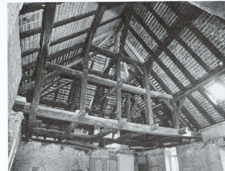
Blick in die Osthälfte des nur auf den Aussenmauern aufruhenden Walmdachstuhles über dem Palas, aufgerichtet im späten 14. Jh. Zustand Mai 1987.
