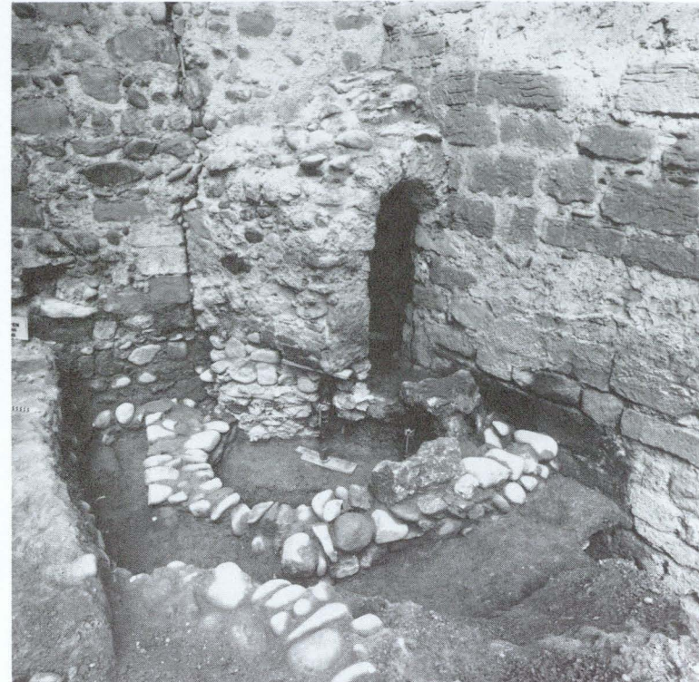
Die als «Hexenkämmerli» bezeichnete Schiessscharte des 17. Jh. im Schlosshof. Davor das Fundament eines mittelalterlichen Backofens.
