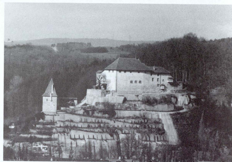
Ansicht von Südosten mit dem sanierten und neu bepflanzten Schlossfels. Links der Käfigturm, erbaut 1660 anstelle eines älteren, vorgeschobenen Wehrturms.
