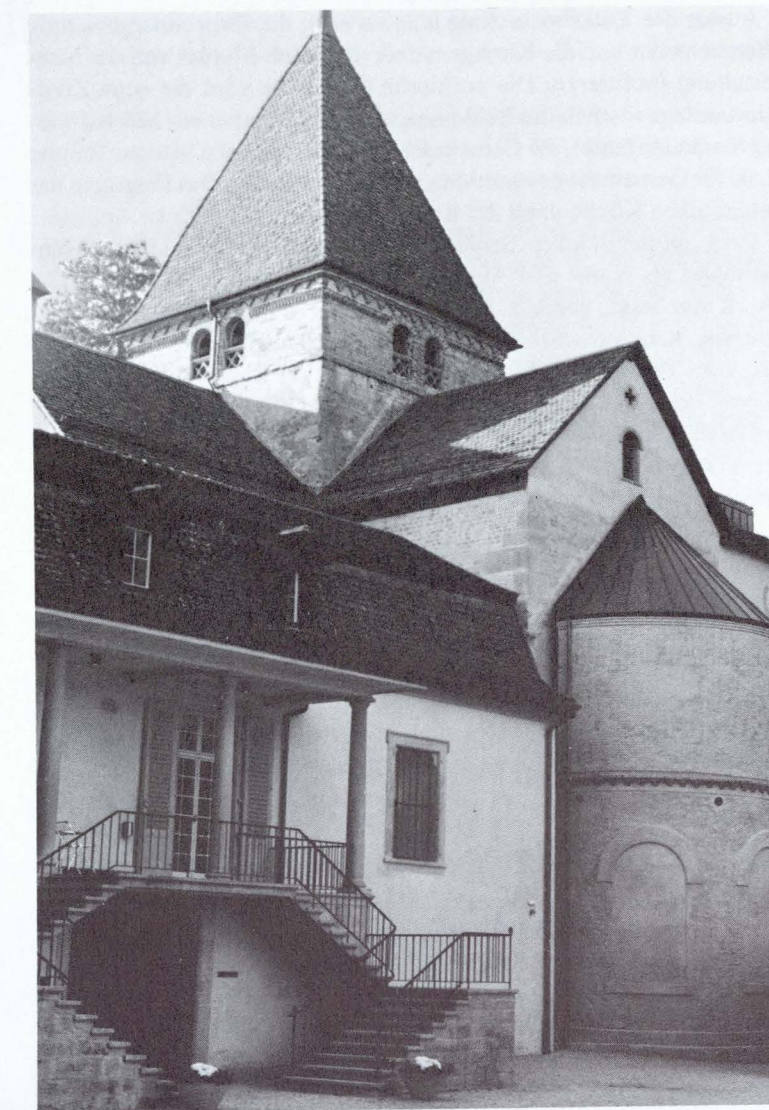
Wieder in originalem Zustand: mit der Höherführung der Hauptaspiz.
