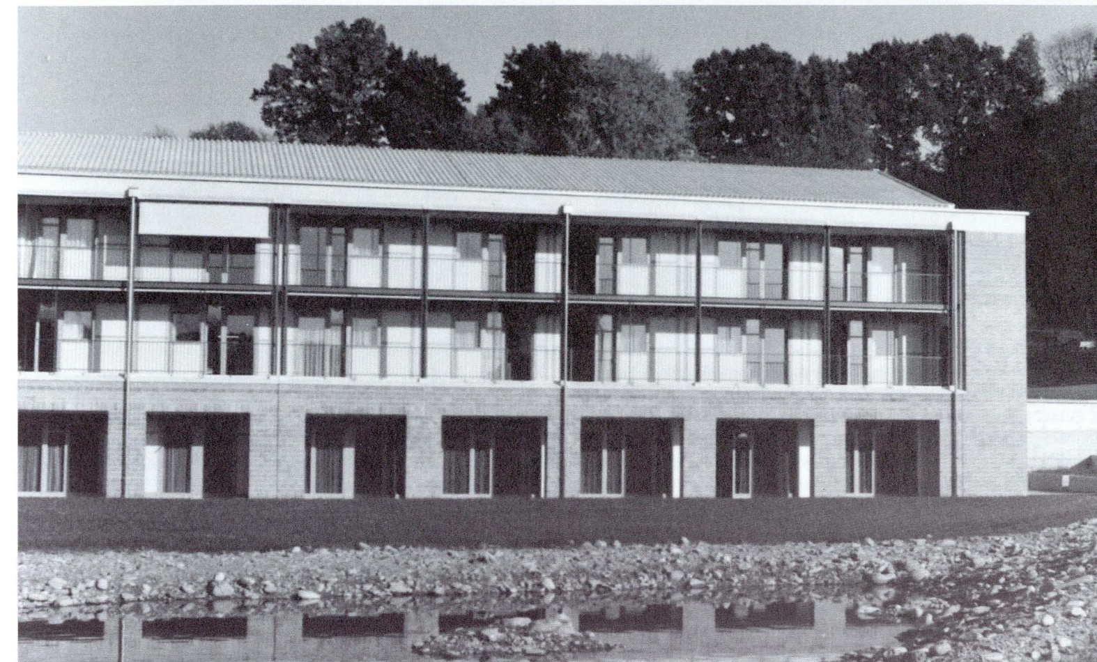
Das langgestreckte, südwestlich orientierte Gebäude dient als Krankenhaus. Im Parterre sind Gemeinschaftseinrichtungen mit Stützpunktfunktion untergebracht. Fotos: A. M. Kohler
