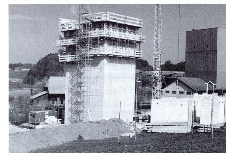
Der 27,4 m hohe Siloturm im Rohbau.
