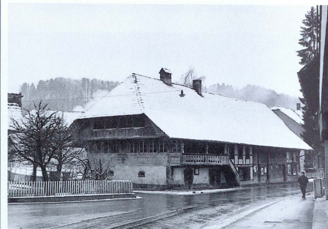
Alte Oele, kurz vor dem Abbruch Foto: Martin Bigler
