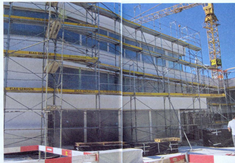
Der neue Kubus im Aufbau
