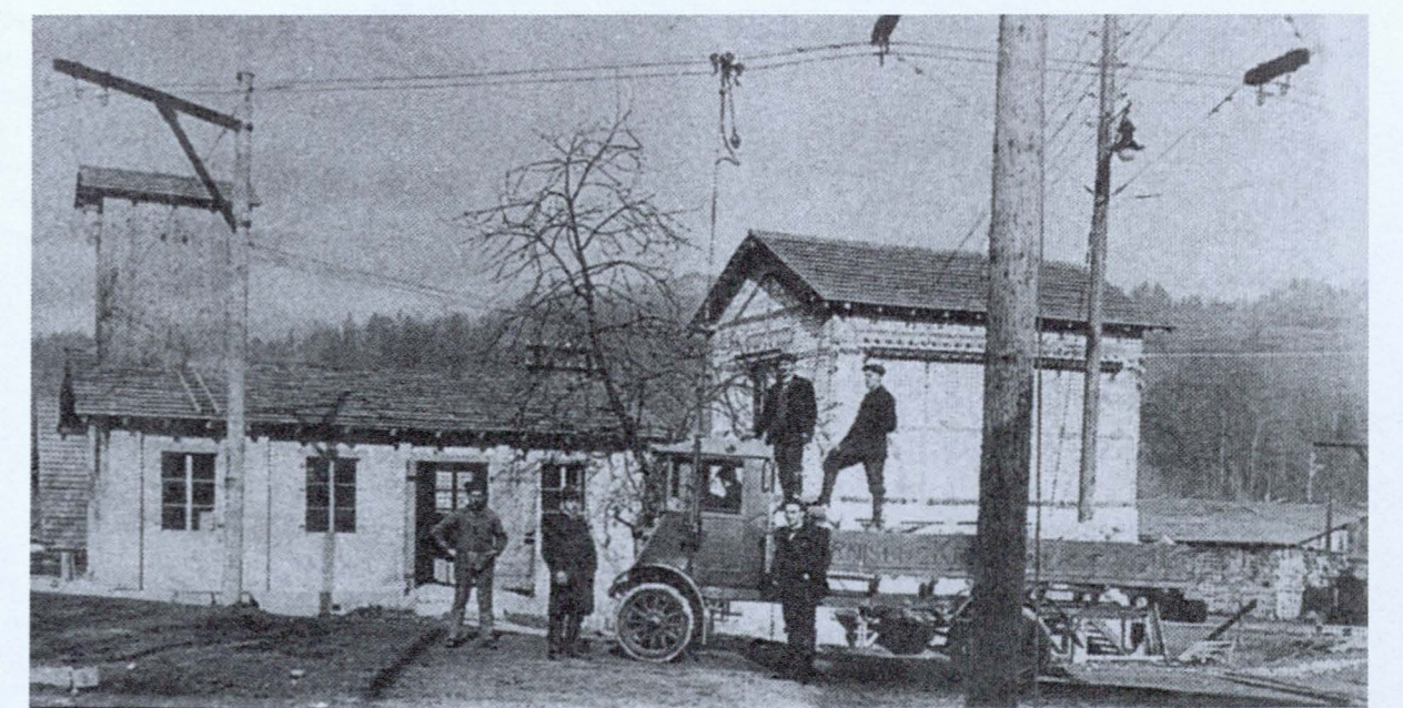
Die Umformerstation und Einspeisung der Fahrleitung auf der Kraftwerkbaustelle Aumatt. Der Wechselstrom aus dem Verbundnetz Hagneck-Kallnach-Spiez wurde hier in Gleichstrom umgeformt. Die Energie wurde über eine hängende Zufuhr (anstelle der heutigen Pantographen) auf das Fahrzeug übertragen.
