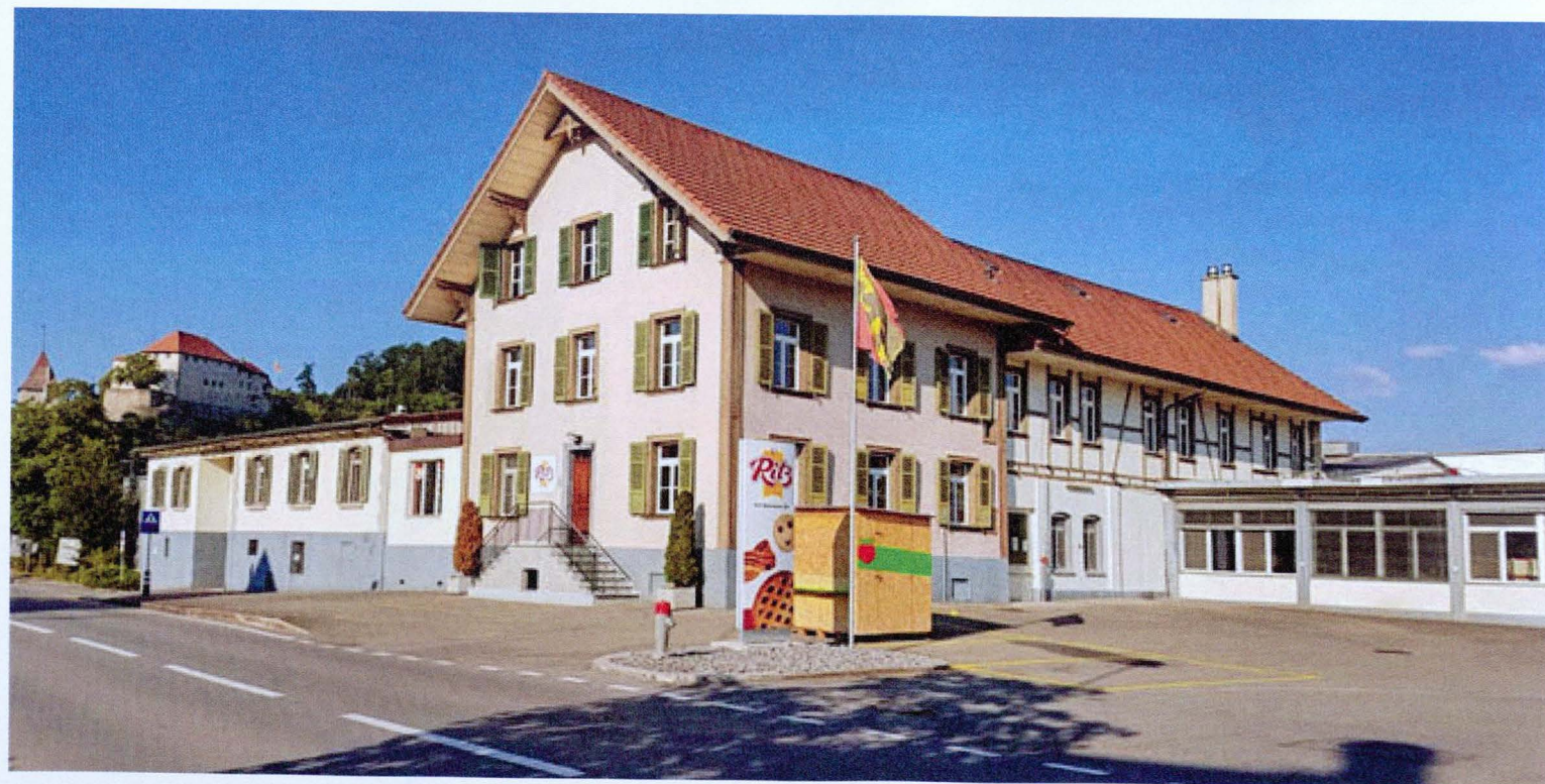
Die alte Fabrik der Ritz AG mit Lagerhalle an der Bösingenstrasse 13.
