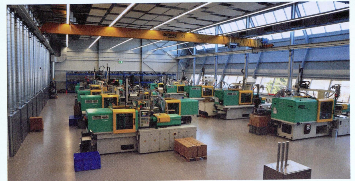
Produktionshalle mit Zuluft links und Abluft rechts.
