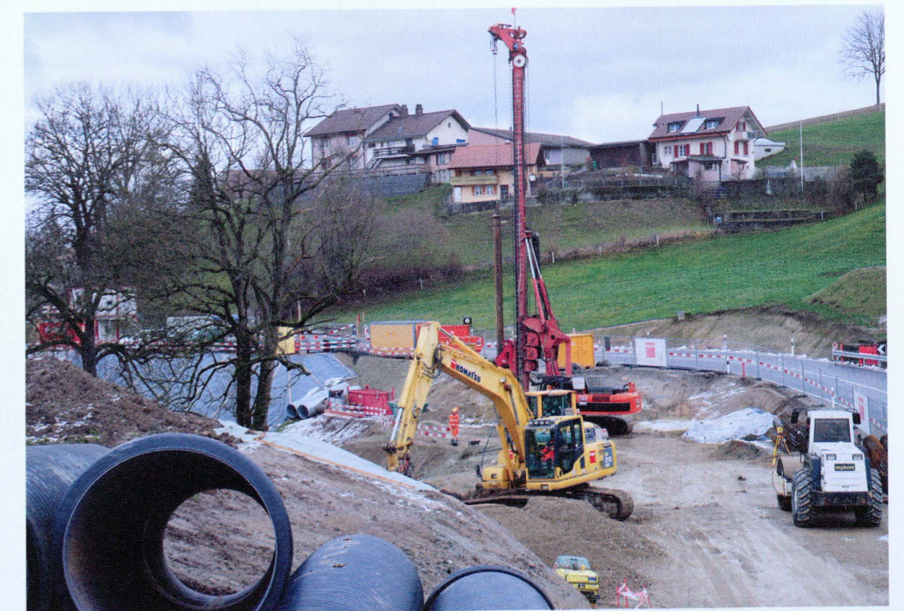
Baustelle am Ort der zukünftigen Brücke.
