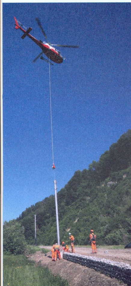
Fahrleitungsmast wird per Heli eingeflogen.
