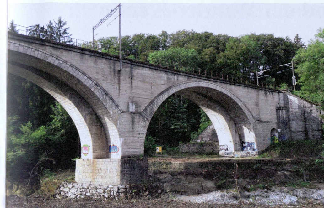
Oben: die Brücke vor der Sanierung.
