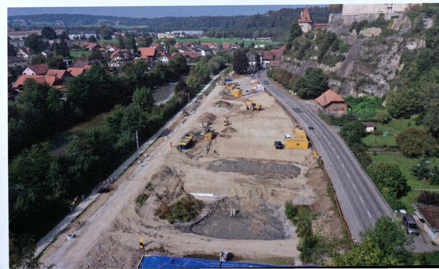
Baustelle Bahnhof mit Bushof. Unten musste der Haldenweiher weichen.
