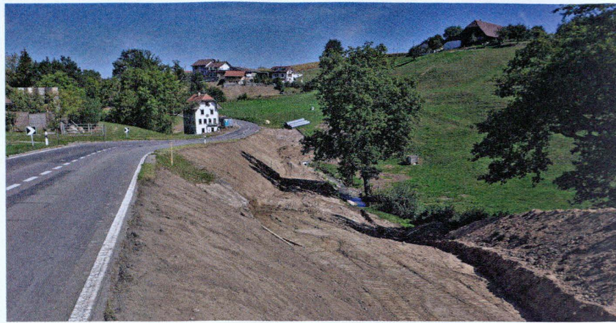
Das alte Haus des Tüftlers Dominik Buntschu († 2016) wurde abgebrochen.
