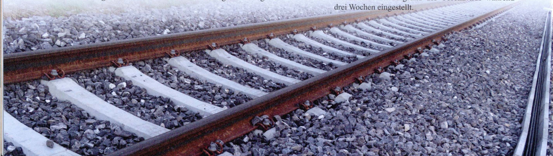
Neues Geleise mit Beton-schwellen, Kabelkanal im Bereich Freiburghaus.
