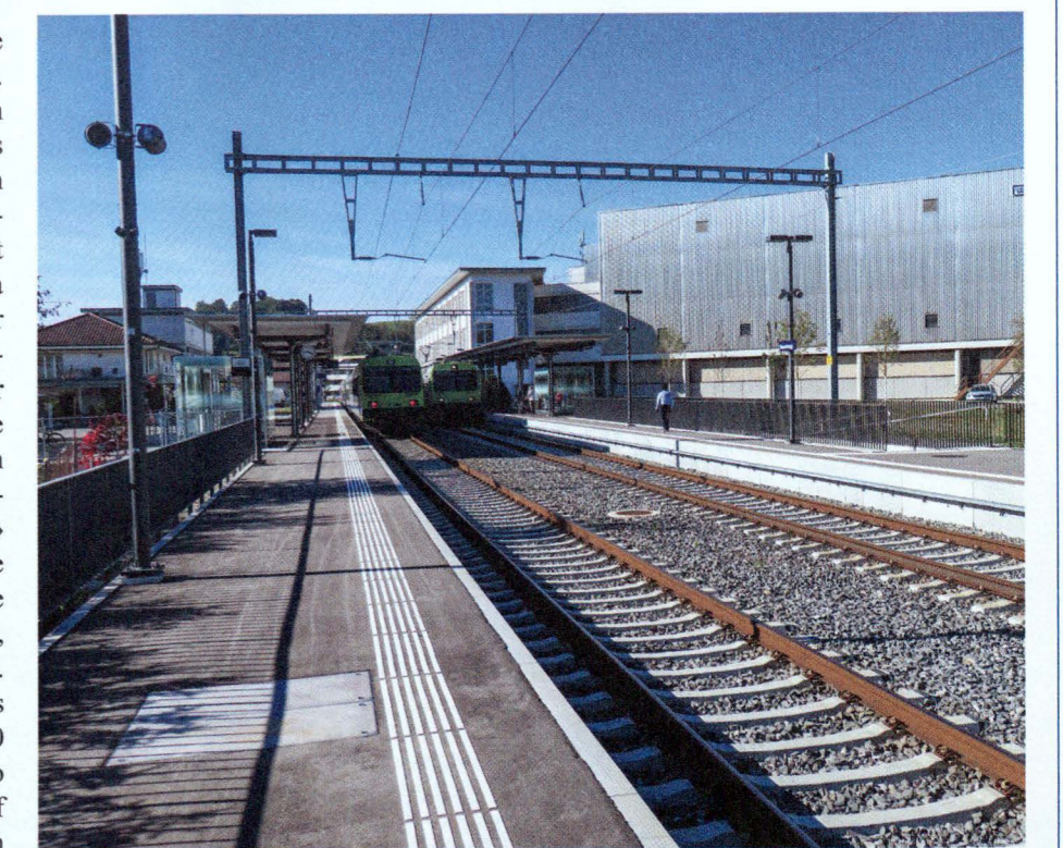
Zwei gedeckte Perrons mit Personenunterführung. Foto: Res Nadig
